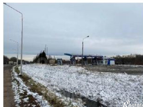
Фото 5. Общий вид АЗС
