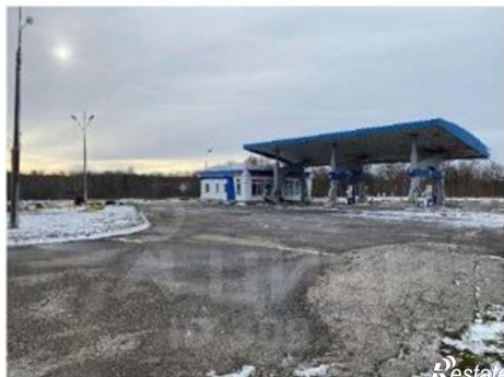
Фото 4. Общий вид АЗС
